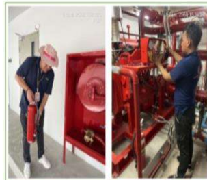
ช่างอาคาร PM ปั้มน้ำดับเพลิง (Fire Pump Engine) ตู้ดับเพลิง (Fire Hose Cabinet)
