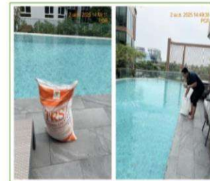
ช่างอาคารเติมสารเคมี (เกลือ) เพื่อปรับสภาพน้ำให้ได้ค่าตามมาตรฐาน
