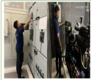
ช่างอาคาร PM ตู้ MDB (Main Distribution Board) เครื่องกำเนิดไฟฟ้า (Generator)
